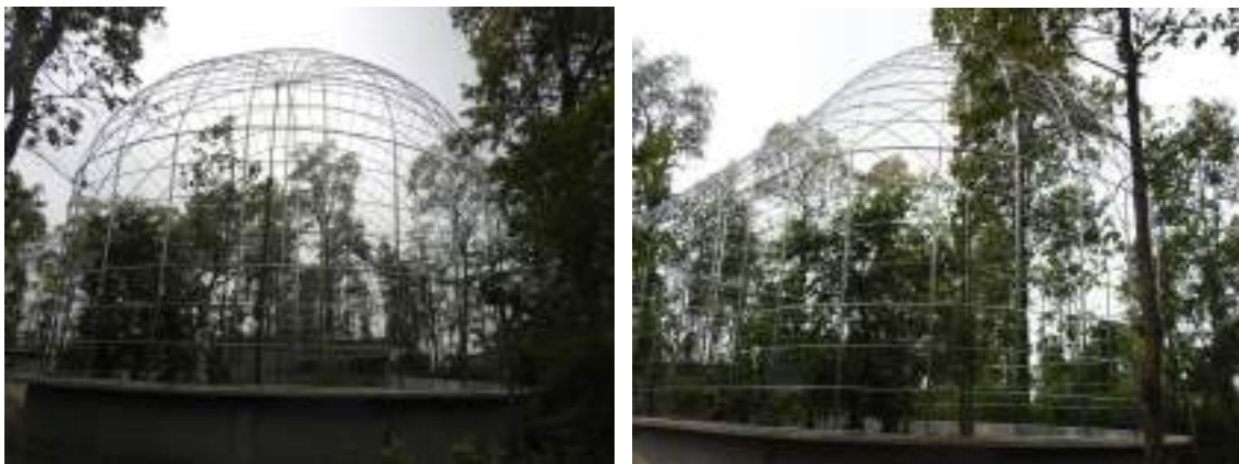
Fig: AV-8, Griffon Vulture Enclosure
